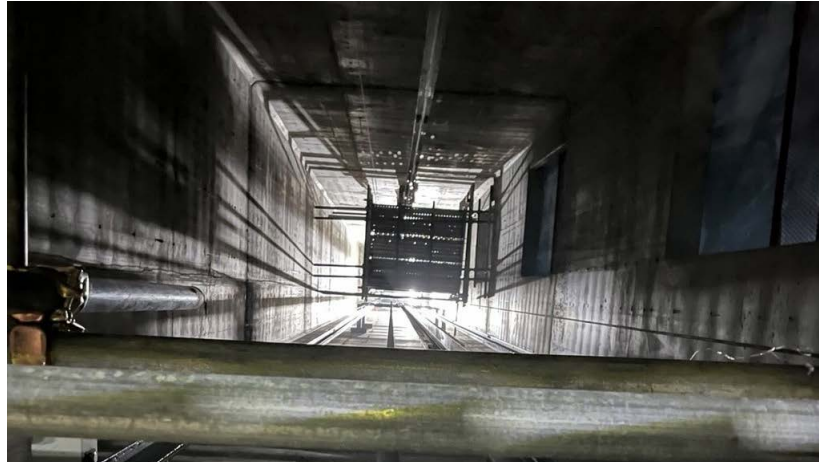
향동지구 건설현장 엘리베이터 공사 당시 개구부 및 비계 모습
